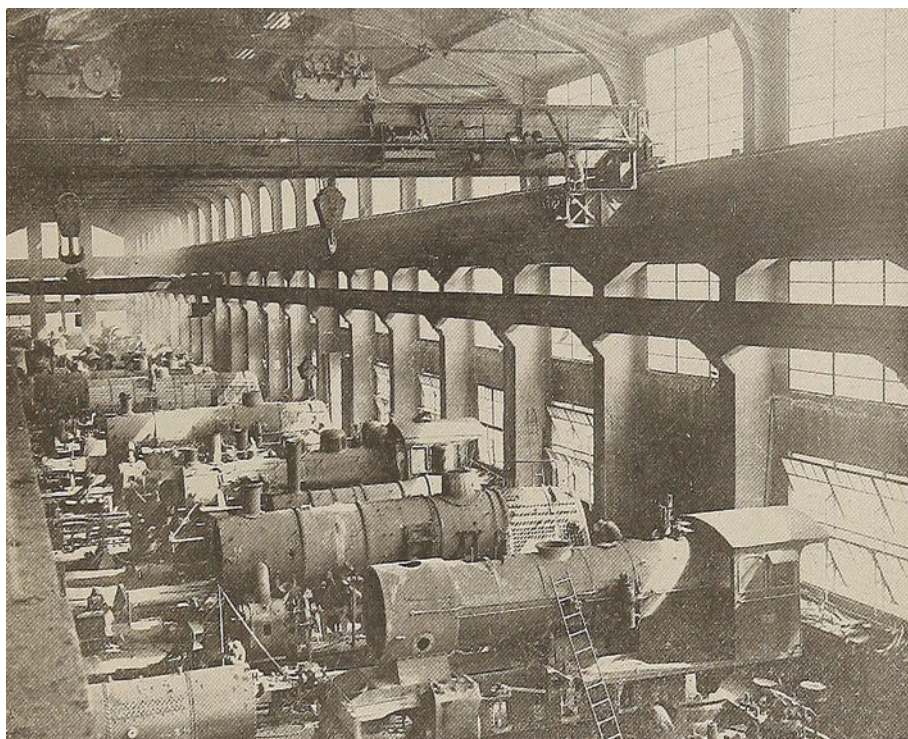
Taller de armaduría de la maestranza de San Bernardo, se puede apreciar la grúa de 120 toneladas
