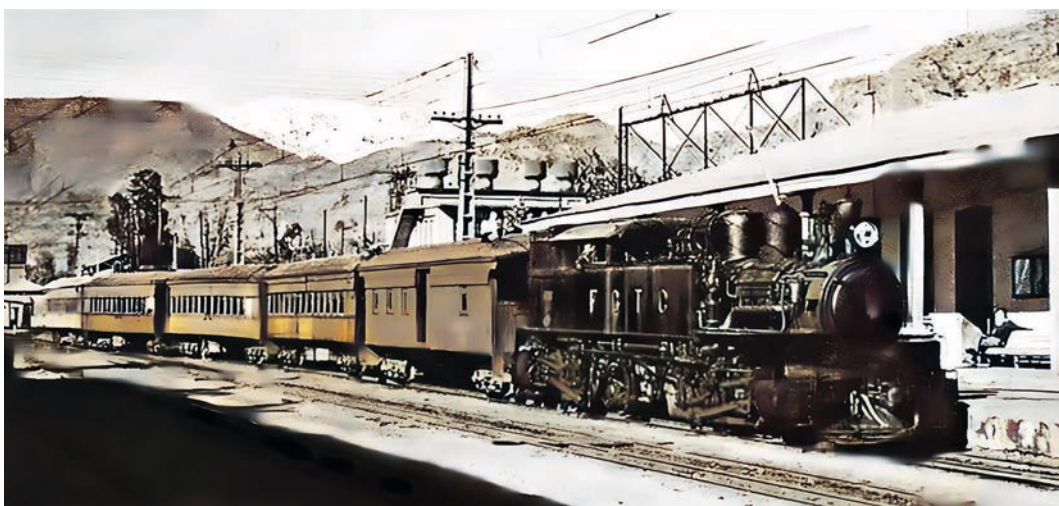
Locomotora tipo Z N°3348 Kitson Meyer
